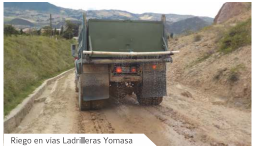
Riego en vías Ladrilleras Yomasa
